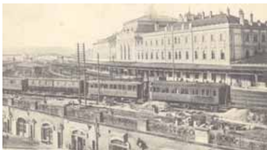
Hlavní nádraží od jihovýchodu – historická fotografie
