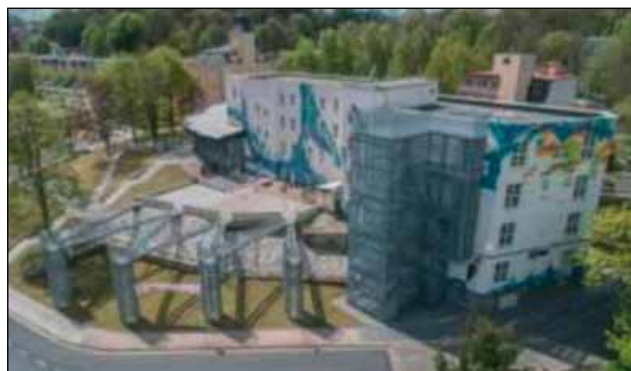
Budova kulturního centra a ZUŠ v Aši po rekonstrukci
