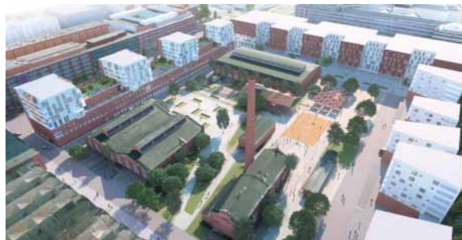
Projekt Teollisuuskatu – revitalizace brownfields, developer NCC
