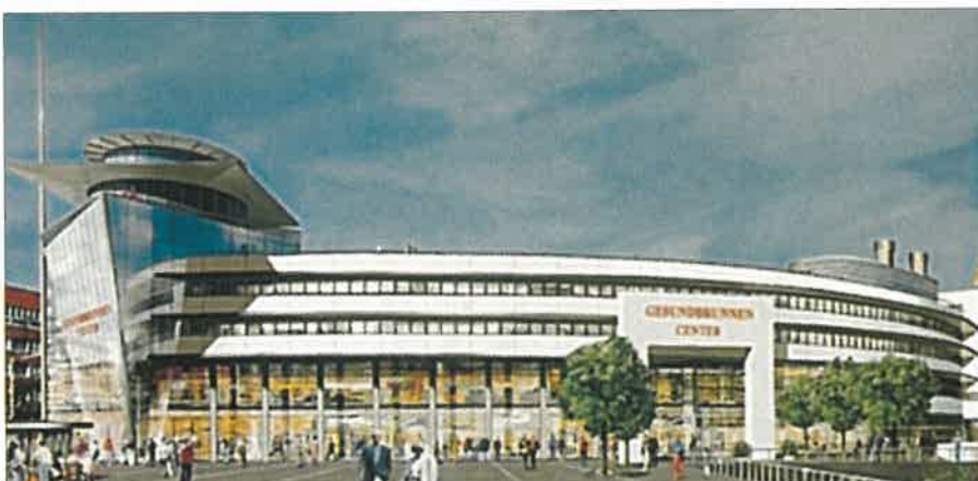
Gesundbrunnen-Center, Berlin: v tradiční blokové zástavbě u významného dopravního uzlu městské hromadné dopravy a regionální železniční dopravy
