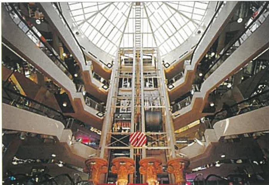
City-Point, Braunschweig: prosklená dvorana s výtahy a eskalátory lemovaná nákupními galeriemi v jednotlivých podlažích
