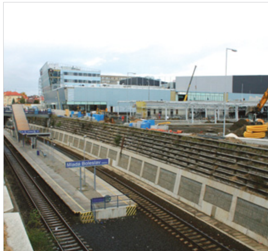
Obr. 7: Bondy Centrum – rozestavěnost na začátku října 2007
