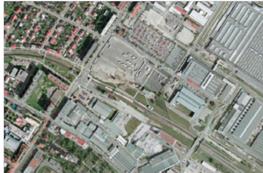
Obr. 3: Ortofoto z r. 2005, po realizaci terénního zářezu železnice a uvolnění plochy po železniční stanici
