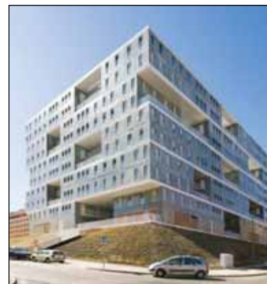
Obr. 6: MVRDV, Celosía, Madrid, 2009
