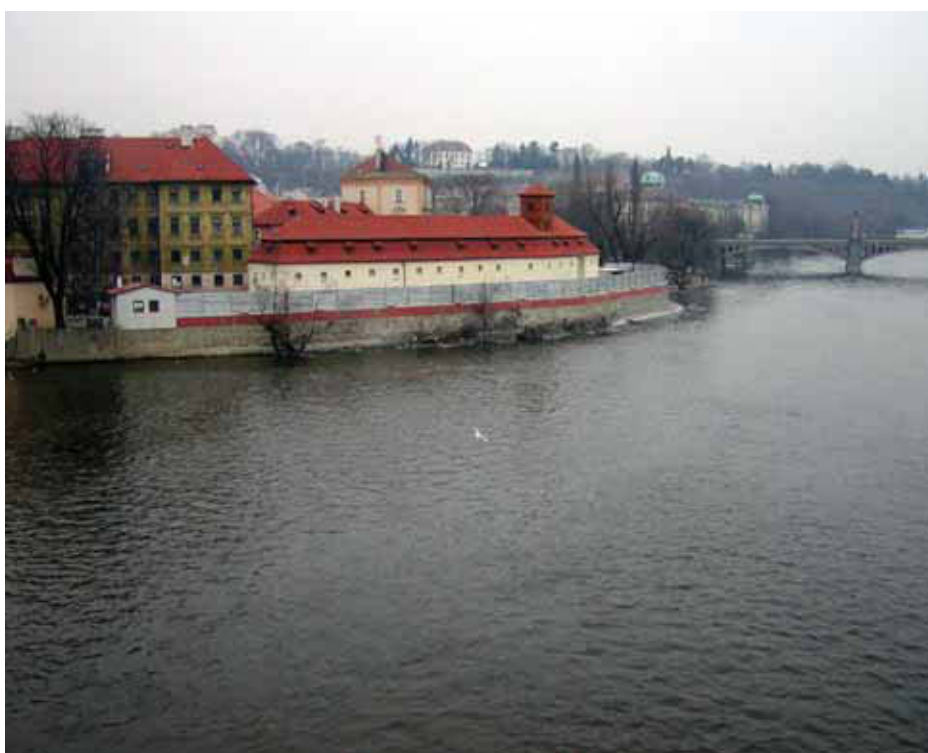
Ochrana Hergetovy cihelny (prosinec 2002)
