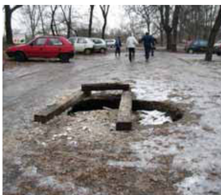
Do podzemních chodeb pronikající zemina vytváří pod povrchem země dutiny, které se postupně propadají
