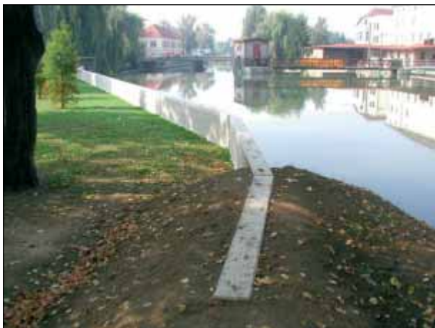
Peliny, centrum města, prvky protipovodňové ochrany (zemní val přecházející v železobetonovou stěnu)
