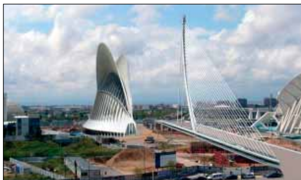
Nový most a polyfunkční objekt
