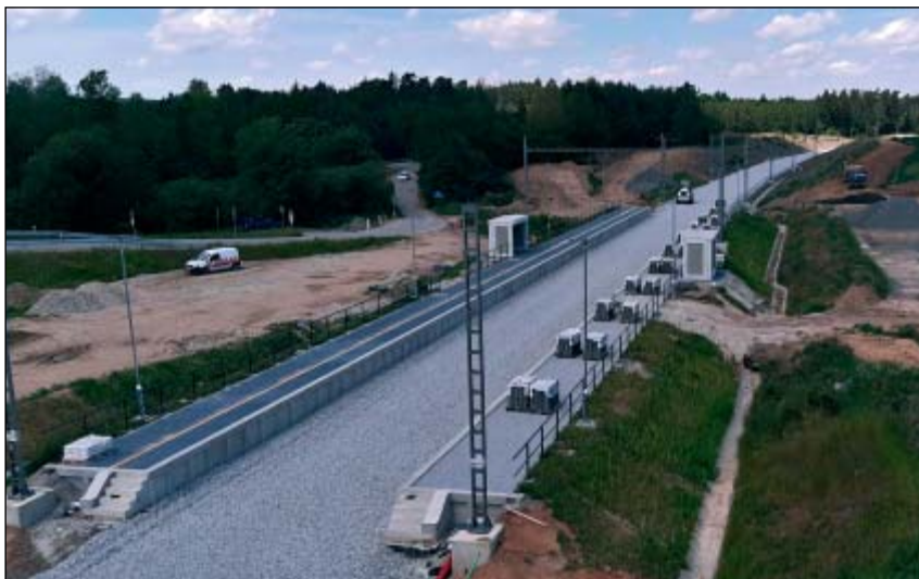
Stavba nové železniční trati mezi Tábořem a Soběslaví
