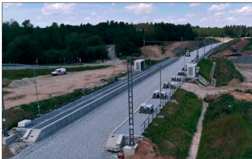
Stavba nové železniční trati mezi Táborem a Soběslaví
