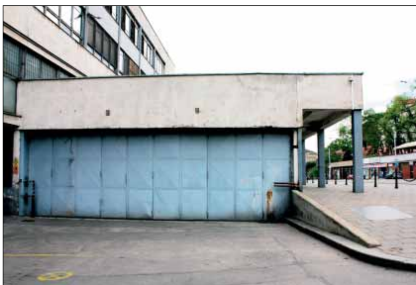
Obr. 7: Problematické místo před budovou České pošty
