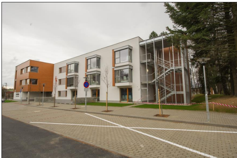
Obr. 33a, 33b: Domov se zvláštním režimem – Seniorpark Valašské Meziříčí, uvedení do provozu 2009
