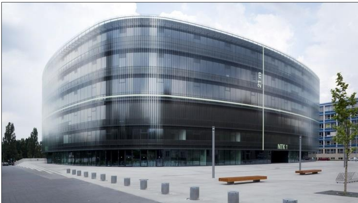
Obr. 13: Národní technická knihovna v Praze (autoři: Projektil architekti, s.r.o., realizace 2006-2008).
