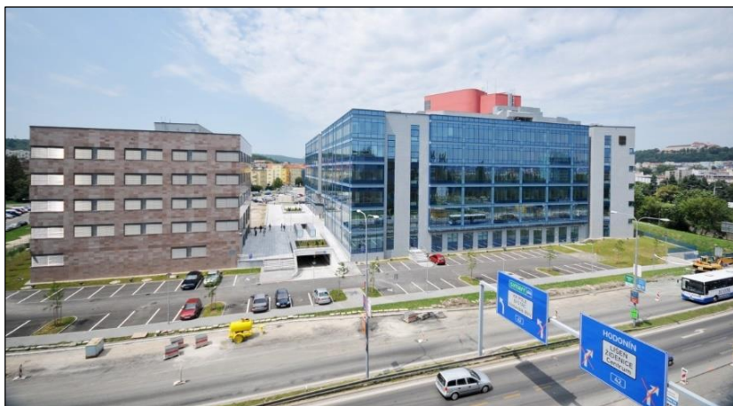
Obr. 44a, 44b: Justiční areál v Brně (autor: Centroprojekt)
