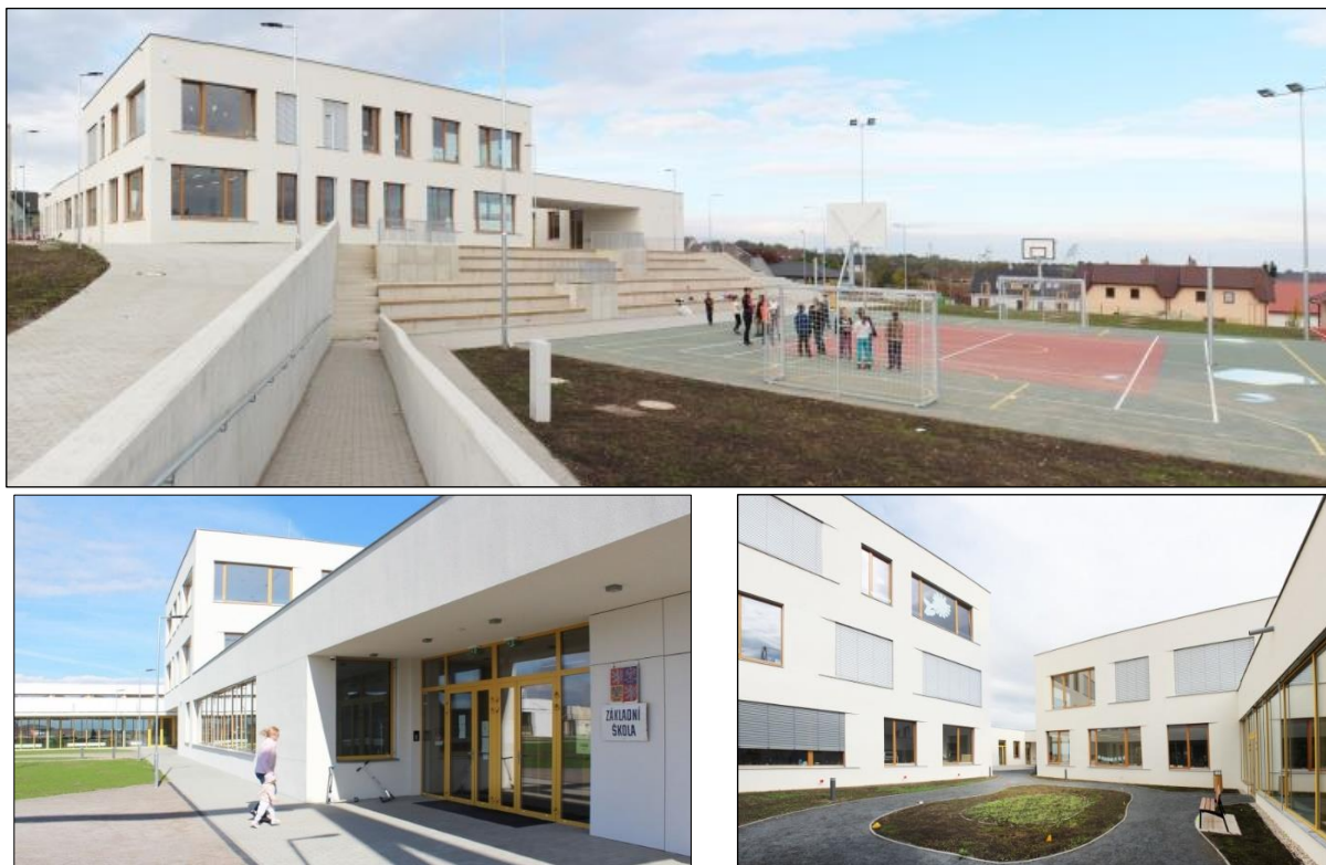
Obr. 25a, 25b, 25c: Základní škola Chýně, autoři: Ateliér CMJN, realizace 2017
