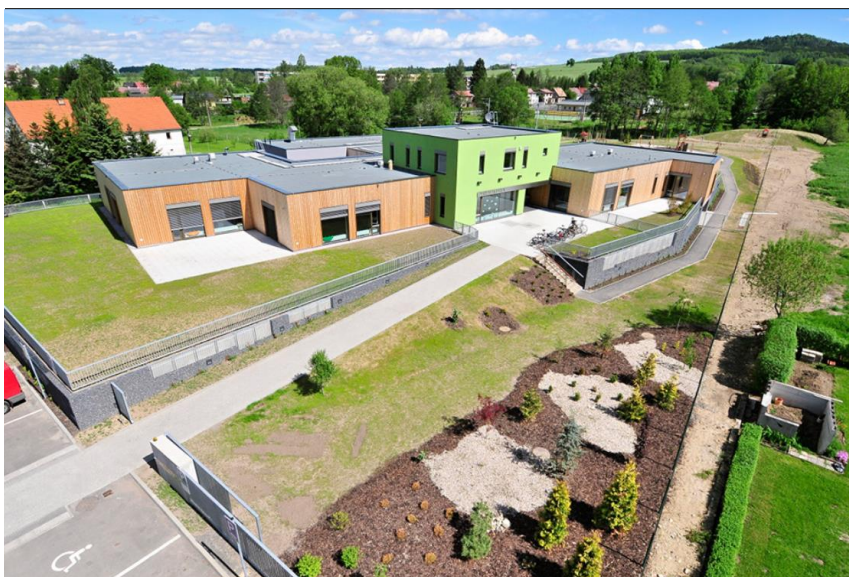
Obr. 23: Mateřská škola v Raspenavě (autor: Projektový ateliér David, s. r. o., realizace 2011)
