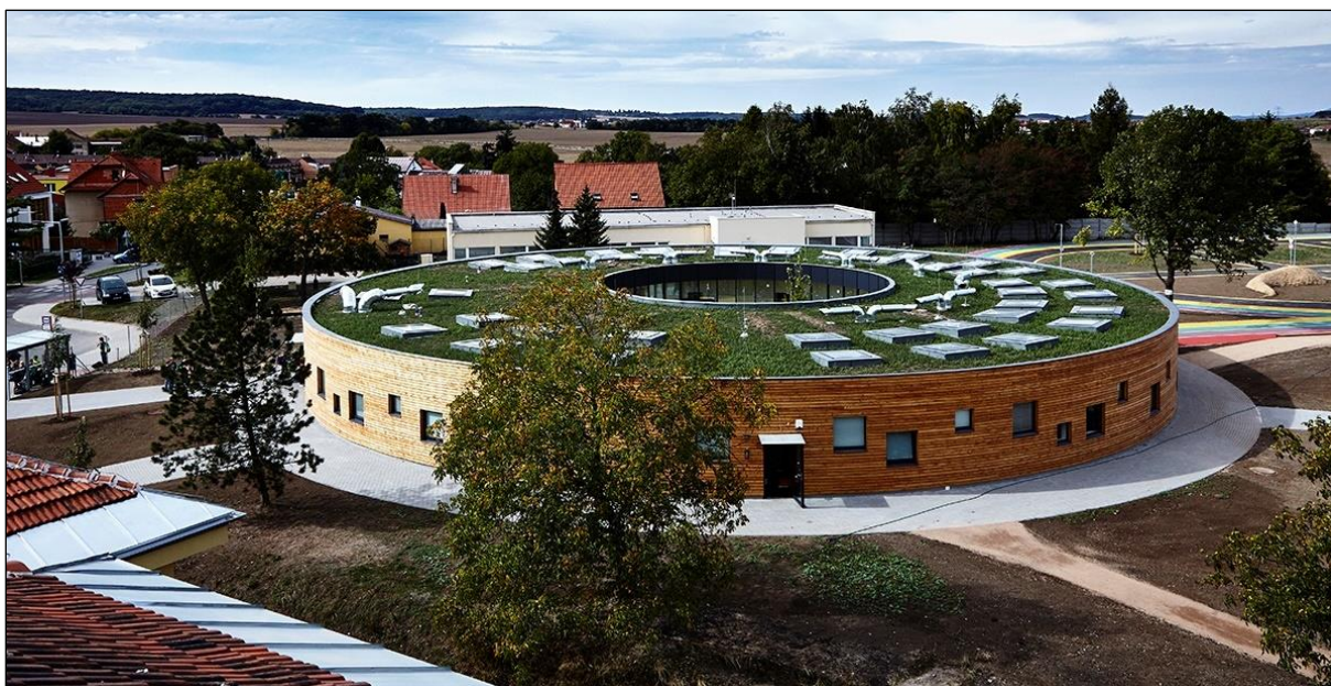
Obr. 8: Nová základní škola a základní umělecká škola v dynamicky se rozvíjející obci Libeznice, v bezprostředním zázemí hlavního města Prahy, v okrese Praha-východ (autor stavby: Projektil architekti, dokončeno 08/2015)
