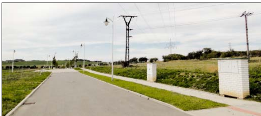
Připravené komunikace a pozemky k prodeji pod elektrickým vedením ve Vysokém Újezdu
