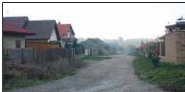
Nedokončené komunikace v obci s povrchem z hrubého štěrku a hlíny (v tomto stavu je v současnosti více než 3 000 m místních komunikací)
