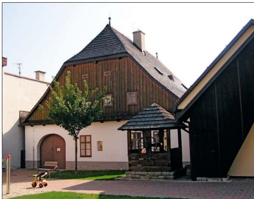
Dům Štěpána Bílka – dvorní průčelí
