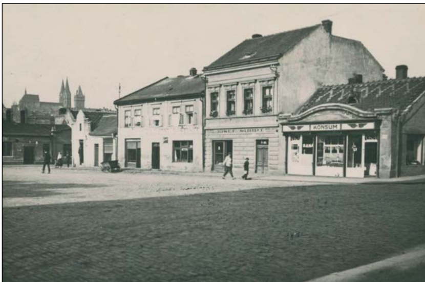
Původní zástavba na západní straně Jiráskova náměstí
