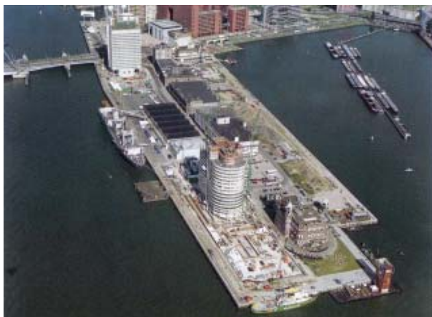
Průběh výstavby na Wilhelminapier
