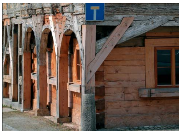
Weißenburg, podstávkový dům, po obnově.
