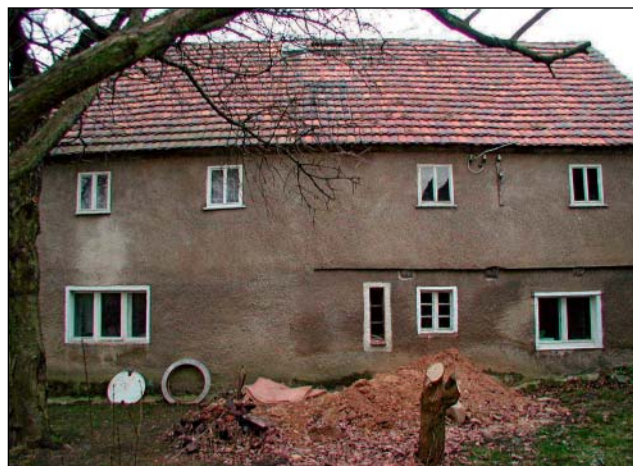
Wadlitz, podstávkový dům, před obnovou
