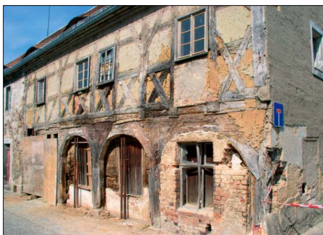
Weißenburg, podstávkový dům, před obnovou.
