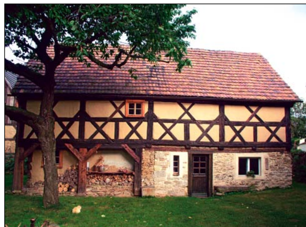
Wadlitz, podstávkový dům, po obnově
