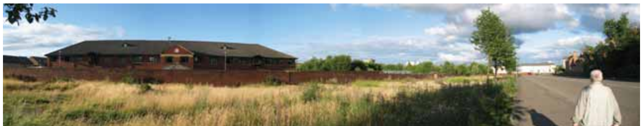
Panoramatický snímek lokality Bilsland Drive, vlevo nově vybudovaný domov důchodců The Westminster Four Hills.
