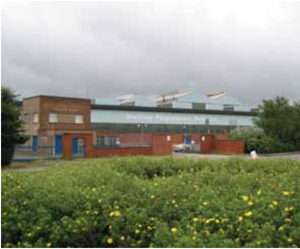
Lokalita Weirs, západní část, hlavní vstup do ocelárny s ukončenou výrobní činností.
