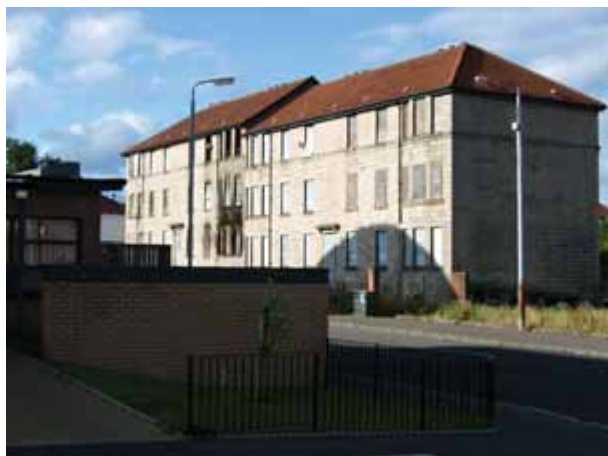
Campbell Street, opuštěné devastované domy.
