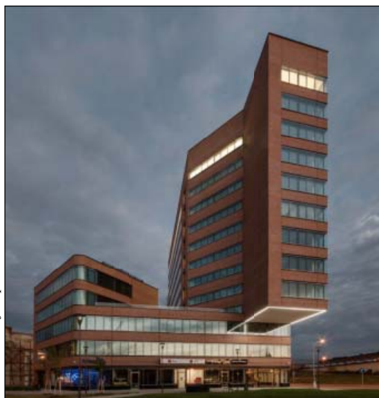
Brno – polyfunkční objekt Dorn (Atelier RAW, s. r. o.)
