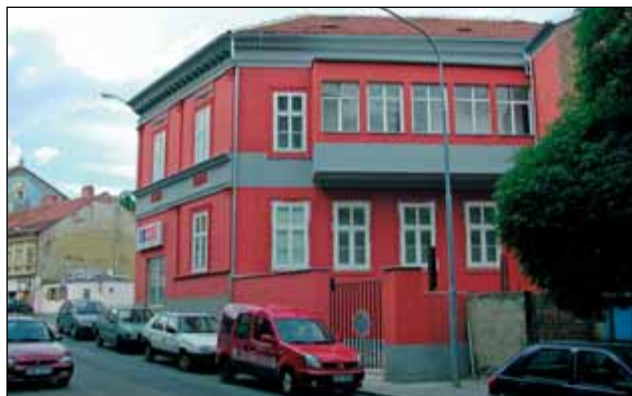
Obr. 11b: Dům na začátku Francouzské ulice po opravě
