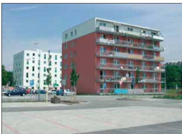
Obr. 7: Nový administrativní objekt „Zderad centrum“ na Křenové ulici byl postaven podle projektu arch. Sátory a Ing. Müllera v letech 2006 až 2007 zároveň s obytnými domy na Masné. Obsahuje 2 330 m 2 komerčních ploch, 2 550 m 2 kanceláří, 197 bytů a 260 parkovacích míst
