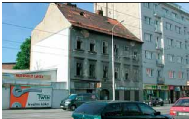
Obr. 9: Vyhořelý klasicistní dům na Křenové ulici. Objekty v takovémto stavu na hlavních ulicích jsou skutečnou ostudou města
