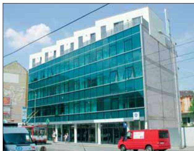
Obr. 6: Nový administrativní objekt na Křenové ulici Foto © Vilém Walter
