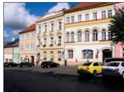
Ústěk 8 – fasády domů
