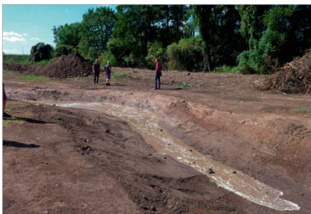
Vodohospodářská slavnost 3. září 2019: První napouštění vody do revitalizačního koryta Říčanky pod pražskou Dubčí. Následně se budou do dna koryta vkládat kamenné pohozové pasy a vytvářet struktury říčního dřeva
