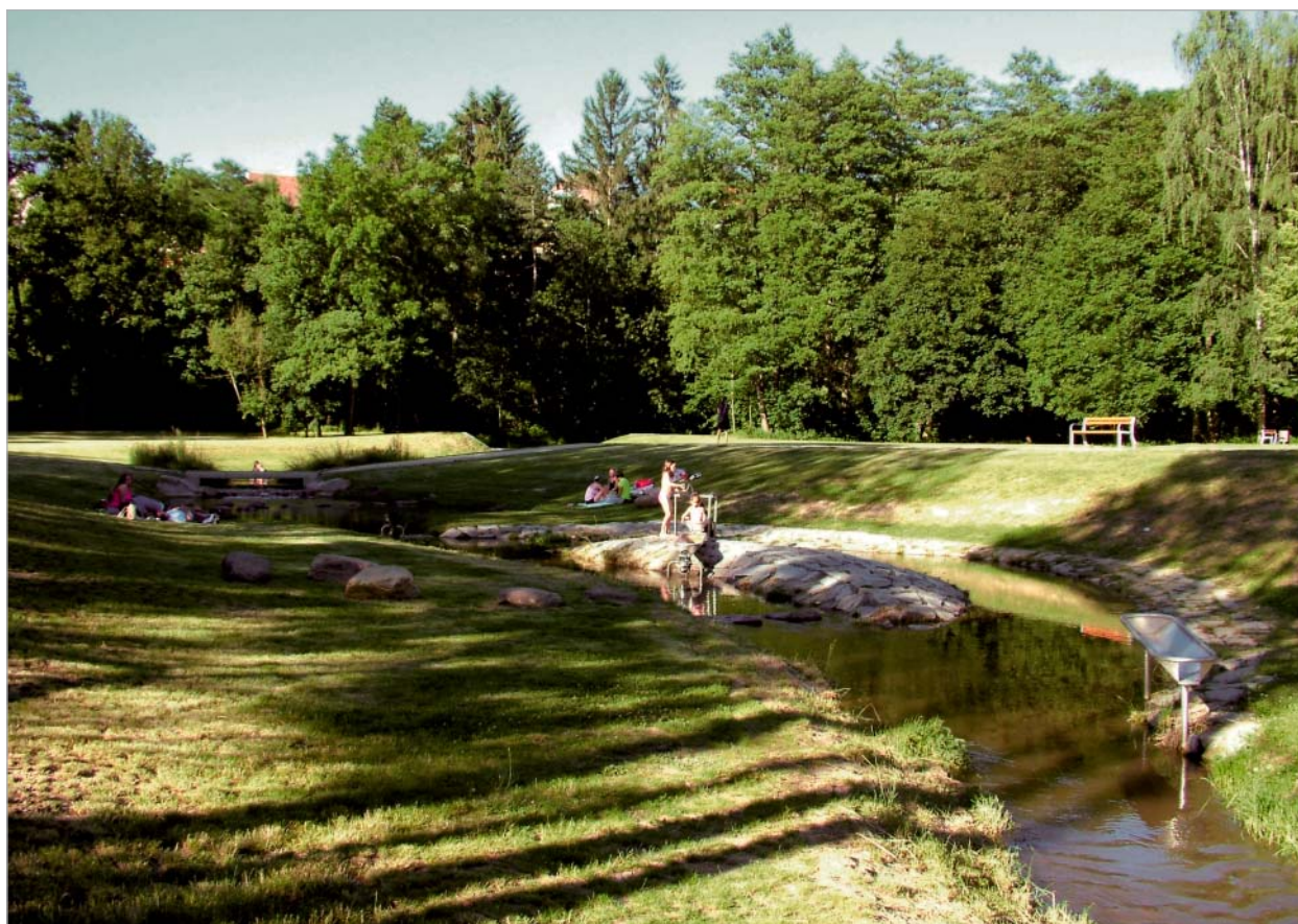
Obr. 3 Nová vodoteč a protipovodňový průleh s dětskými herními prvky
