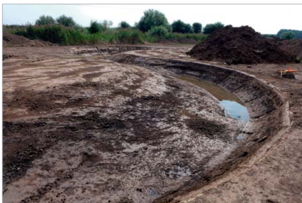
Revitalizační novinka podletí roku 2019: Hlavní město Praha za svoje peníze revitalizuje zhruba ¾ kilometru Říčanky pod Dubší, pod současně rekonstruovaným rybníkem Litožnice. Nové, přírodě blízké koryto, vyhloubené v souladu s moderními poznatky říční morfologie, čeká na zavedení průtoku
