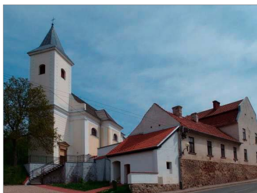
Kostel a fara.
