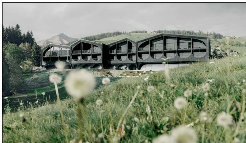
Výstavba hotelu Milla Montis v Itálii o rozloze 3 500 m 2 byla zhotovena za 6 měsíců. Rychlost stavby byla možná jen díky velké míře prefabrikace a použití lokálního dřeva jako hlavního materiálu.
