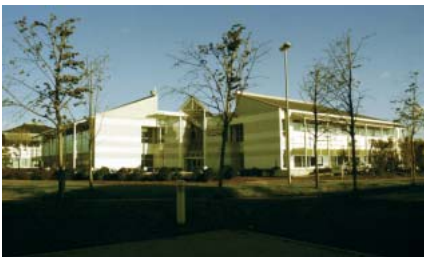
Typický objekt první fáze výstavby, navržený architekty Arup Associates
