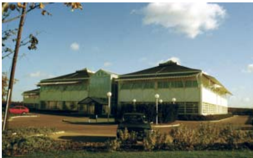
Objekty pro vývoj prodejních technologií firmy Marks and Spencer (38 000 m 2 ), Arup Associates
