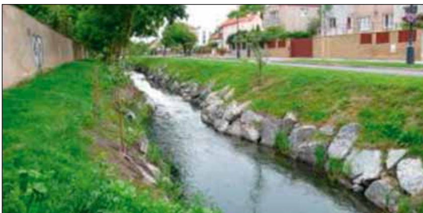
Zdroj: Revitalizace vodních toků, Ing. Tomáš Just, Agentura ochrany přírody ČR, březen 2012
