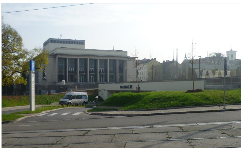
Obr. 16, 17: Nová realizace veřejného prostranství na střeše podzemních parkovacích garáží před Janáckovým divadlem v Brně
