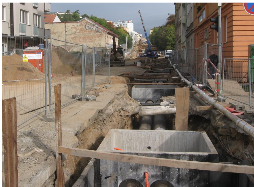
Obr. 50: Zásadní rekonstrukce inženýrských sítí
