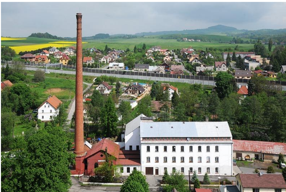
Obr. 7: Továrna na sukno – Chrastava. Rozkošná fabrika se snad nejštíhlejším komínem v ČR prošla v minulosti konverzí. Bývalé výrobní budovy slouží majitelům k podnikání a bydlení, z kotelny se stala restaurace se stylovým názvem "U komína".
