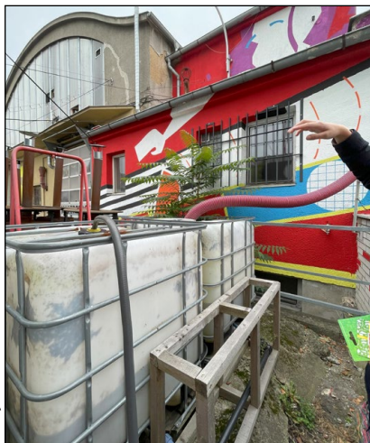
Nádrž v komunitní zahradě zachytává dešťovou vodu ze střechy okolní budovy a ukazuje, jak lze jednoduchými řešeními podpořit udržitelnost ve městě
