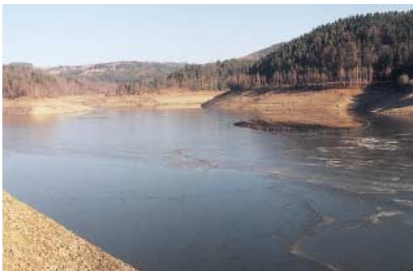
Obr. 5: Zdroj pitné vody města – Vírská přehrada při mimořádně nízkém vodním stavu (březen 2001)
