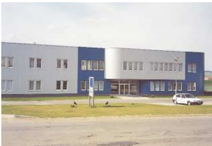
Obr. 3: Nová budova německé firmy Rathgeber v Bystřici nad Pernštejnem
