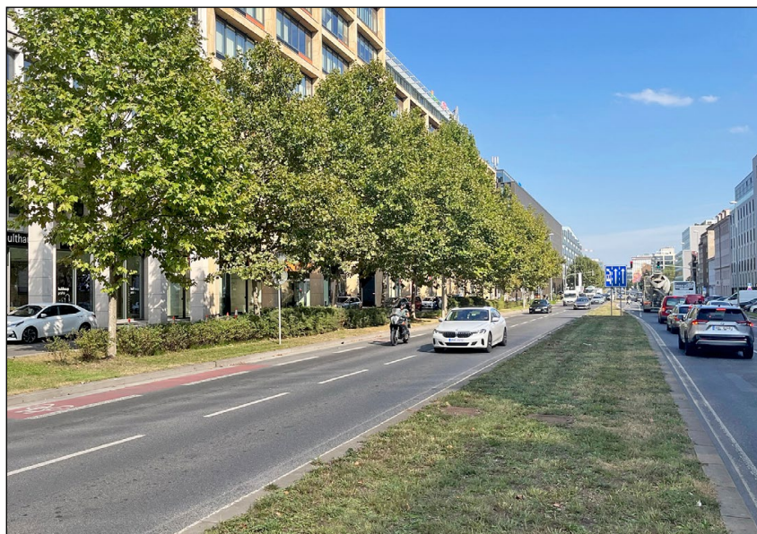
Obr. 9: Rohanské nábřeží, Praha – dělicí pásy nenechaly žádné místo pro severní chodník
