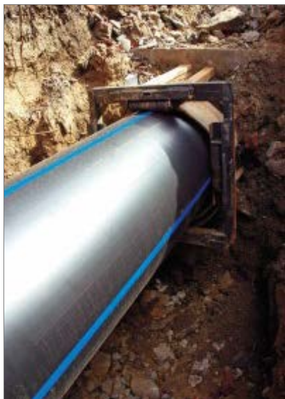
Obr. 47a, 47b: Prostý relining.
