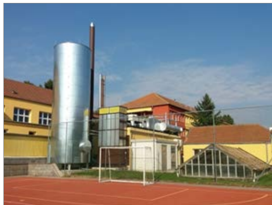
Obr. 37: Kogenerační jednotka Oslavany.
