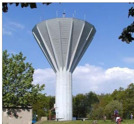
Obr. 11: Věžový vodojem Kohoutovice.
