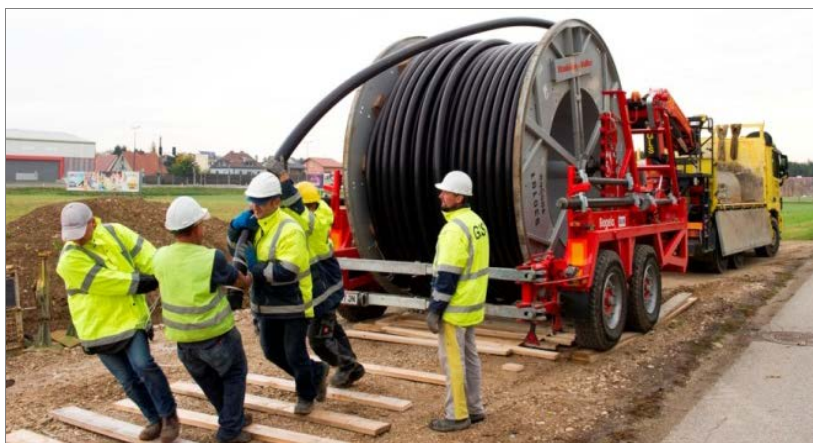
Obr. 1a, 1b: Kabelové vedení velmi vysokého napětí 110 kV a jeho pokládka.
