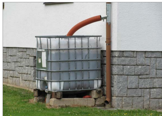
Obr. 14: Příklad zadržení části srážkové vody k jejímu využití pro zalévání či i jiné účely.
