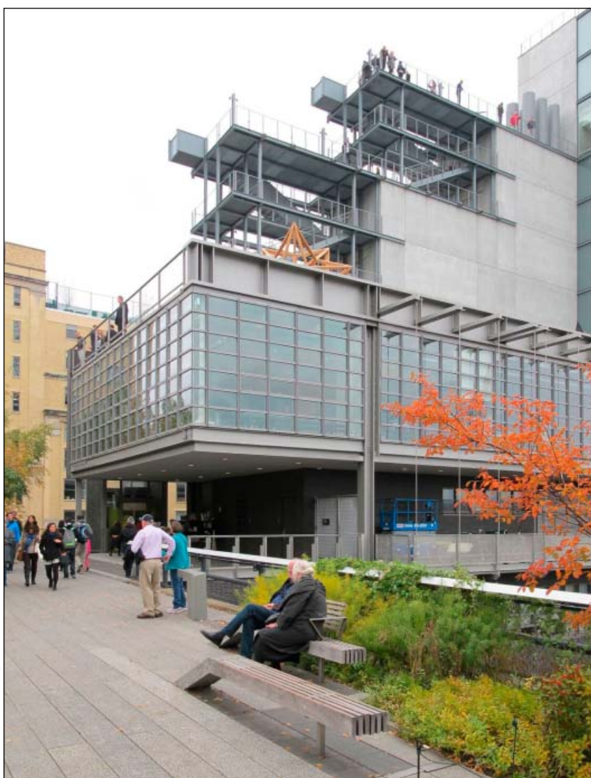
V popředí prosklená fasáda provozní a správní budovy parku High Line, realizované v roce 2014 prováděcí firmou Beyer Blinder Belle, podle návrhu firmy Renzo Piano Building Workshop, provozně propojené s High Line. V pozadí visuté terasy budovy Whitneyho muzea amerického umění (R. Piano 2015). Obě budovy jsou umístěny při jižním nástupu do parku High Line z křižovatky ulic Gansevoortova a Washingtonova.
