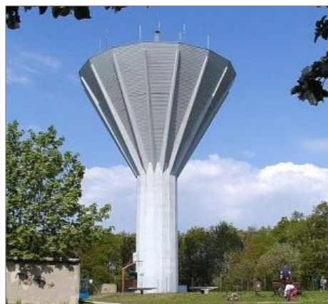
Obr. 11: Věžový vodojem Kohoutovice.
