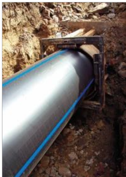
Obr. 47a, 47b: Prostý relining.
