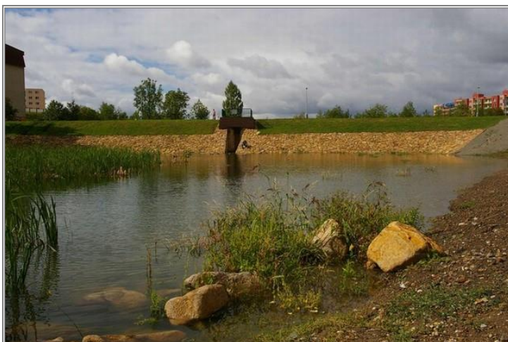
Obr. 24: Retenční nádrž – Černý most.
