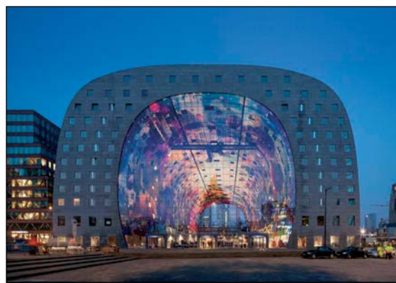
Rotterdam, Markthal – krytý trh (MVRDV, 2014)
