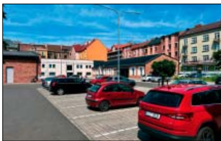
MPZ Český Těšín bývalé papírny, Full Black Series 430–450 Watt od firmy SUNTECH fotovoltaické panely
