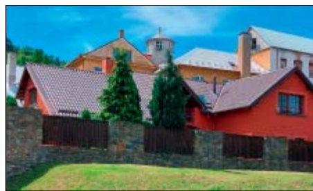
MPZ Fulnek – pohled ze dvora s FVZ taškami na střeše
