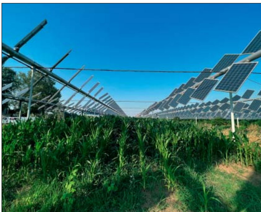
Duálně natáčecí horizontální agrovoltaický systém, REM TEC SRL, Itálie
