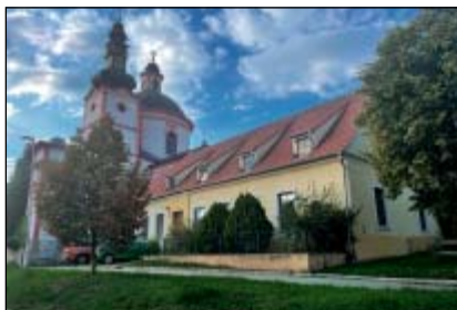
MPZ a OP MPR Znojmo před instalací FVZ (Zdroj: NPÚ)
