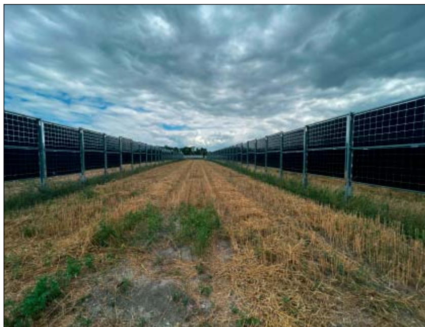
Vertikální agrovoltaický systém – pěstování konvenčních plodin, WienEnergie, Rakousko
