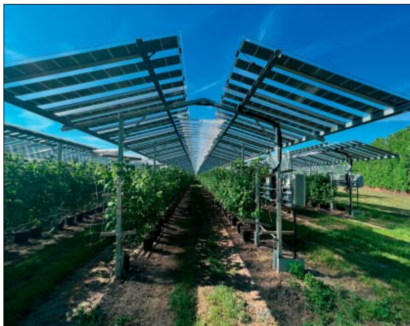
Horizontální agrovoltaický systém – stříšky s polopropustnými panely, Baywa r.e., Holandsko
