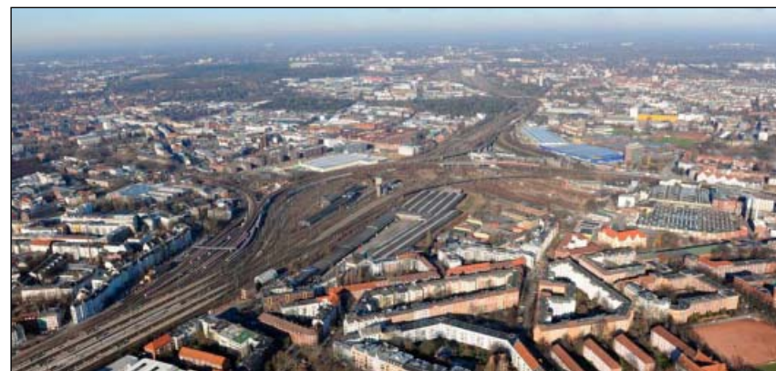
Letecký snímek bývalého nákladového nádraží Altona
