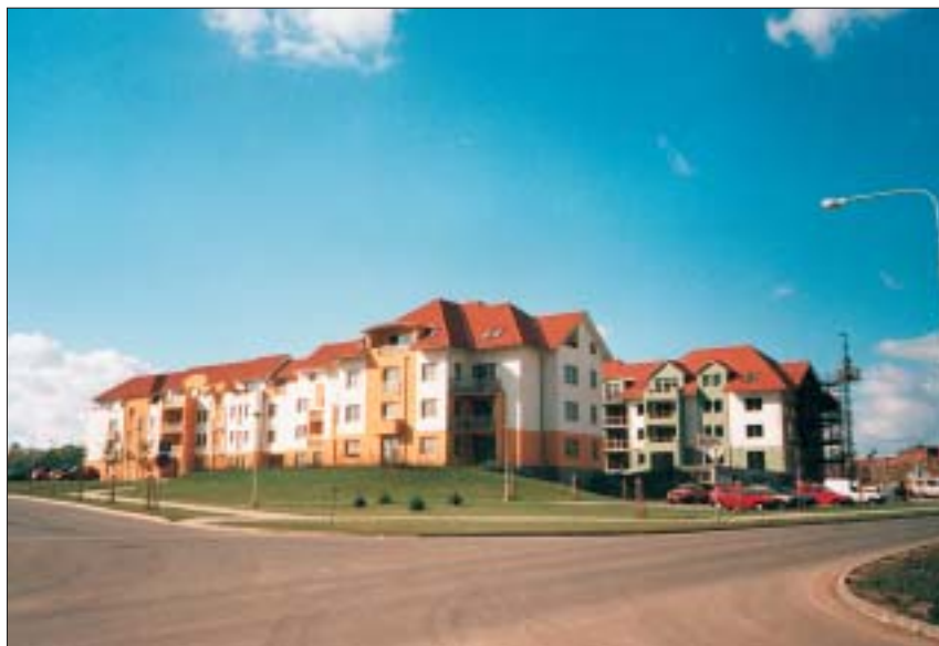
Olomouc – Horní lán, výstavba 170 bytů vyššího standardu
