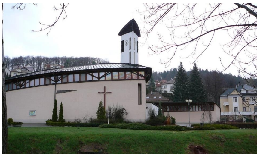
Obr. 59: Farní kostel Svaté Rodiny v Luhačovicích postavený v 90 letech 20. století
