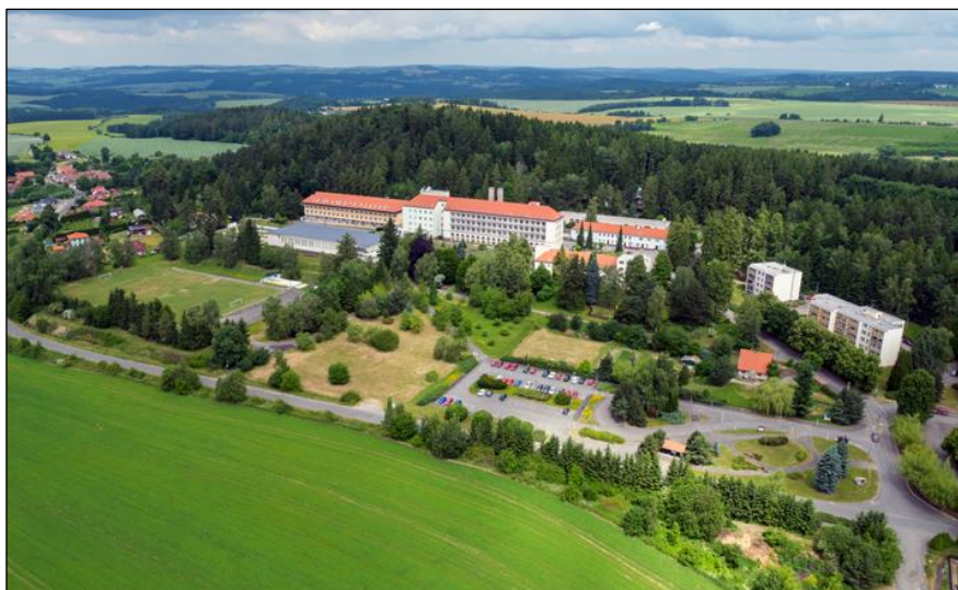
Obr. 39: Rehabilitační ústav Kladruby
