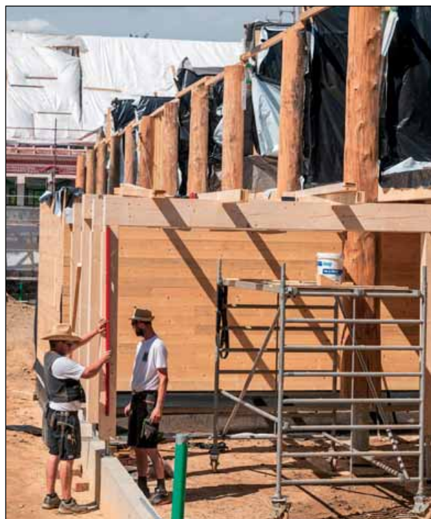
Dřevo z nedalekého durynského lesa a podpora místní dřevařské firmy se spojily na stavbě Státního sportovního svazu.
