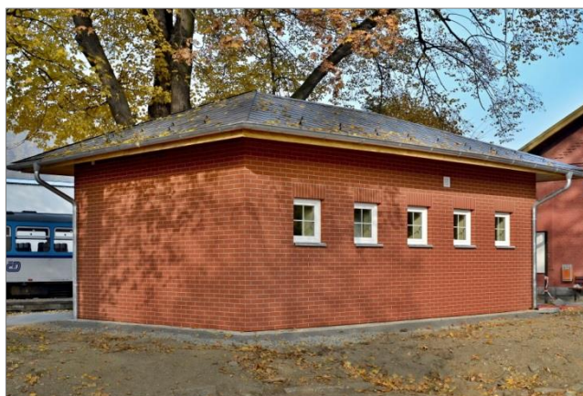
Rekonstrukce veřejného wc
