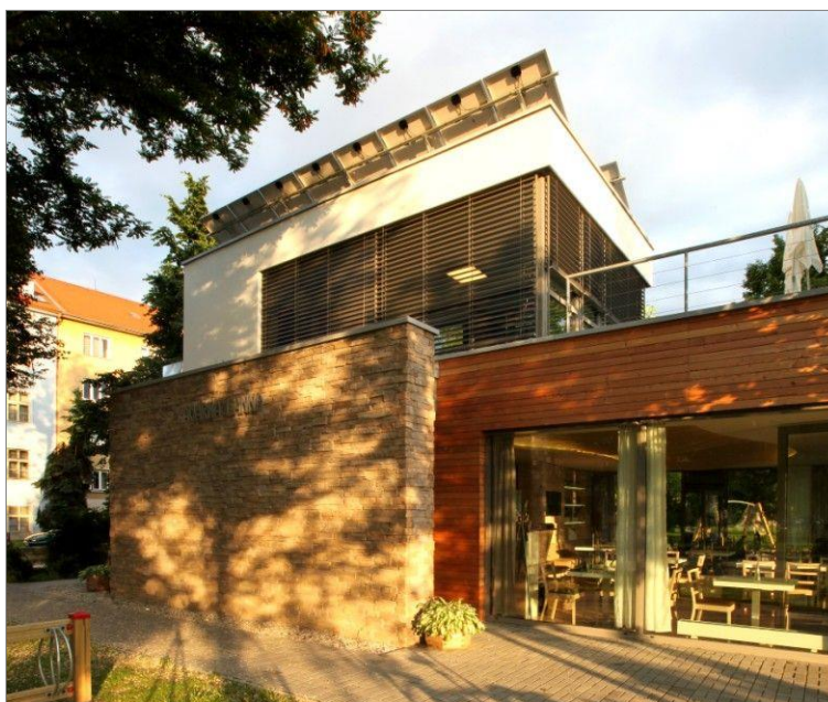
Veřejné WC na Jiráskově nábřeží
