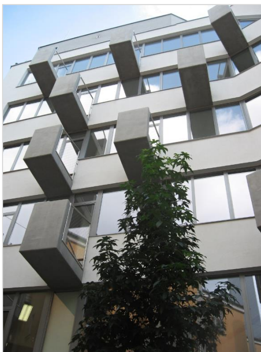
Obr. 30, 31: Kvalitu bydlení ovlivňuje prostředí navazující na byty. Bratislava Foto: Petr Forchgot, Zdeňka Kučerová
