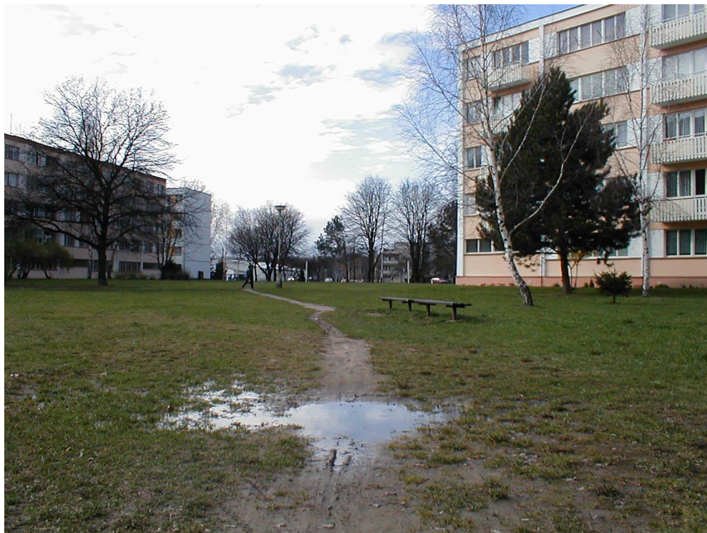
Pardubice, sídliště Pravý břeh Labe – stav před úpravou
