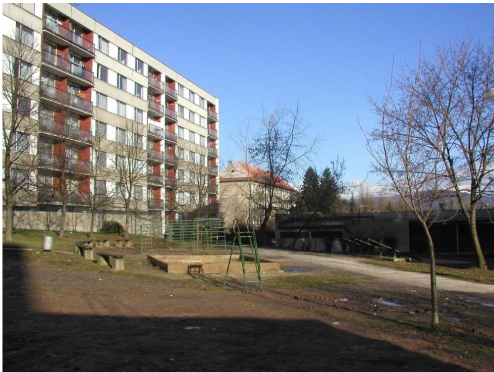
Jilemnice, sídliště Spořilov – stav před úpravou
