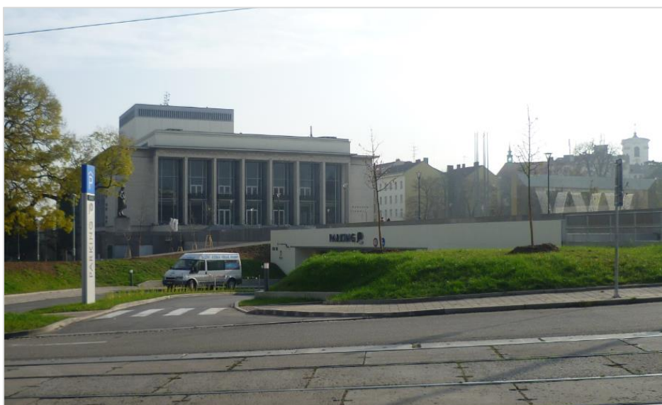
Obr. 16, 17: Nová realizace veřejného prostranství na střeše podzemních parkovacích garáží před Janáčkovým divadlem v Brně
