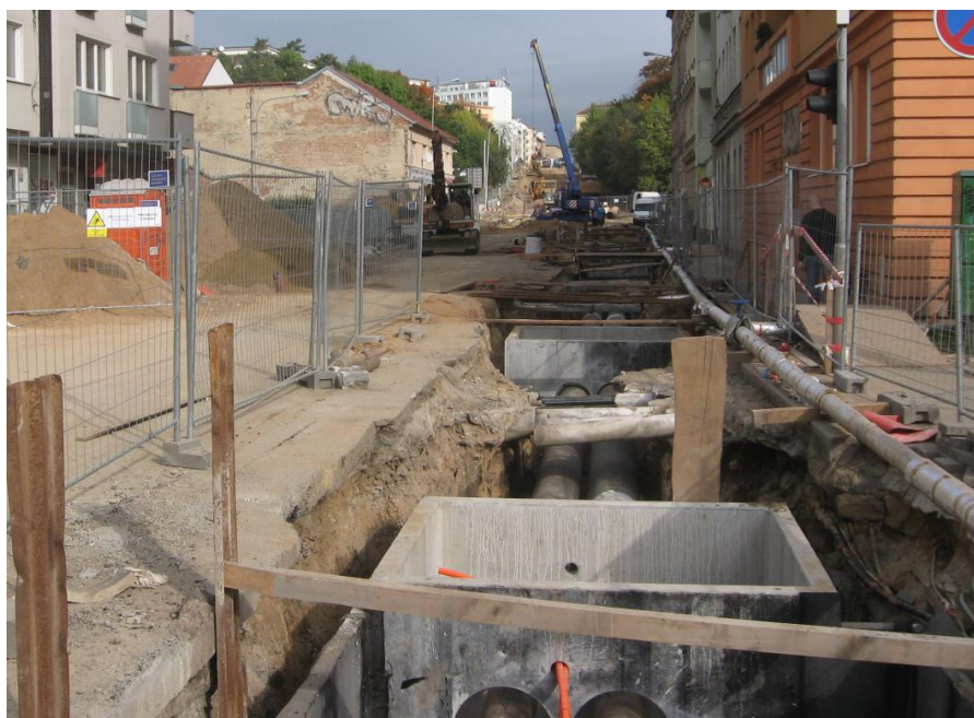
Obr. 50: Zásadní rekonstrukce inženýrských sítí
