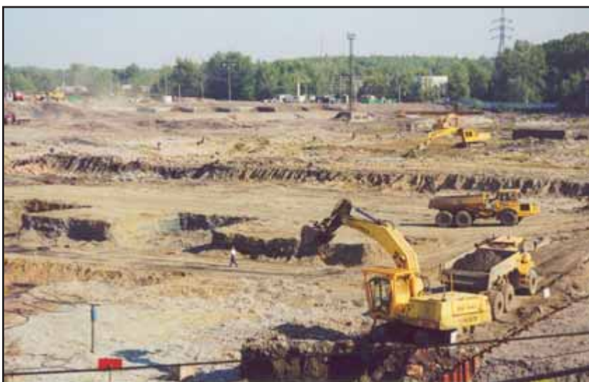
Obr. 6: Dekontaminace - těžení kontaminované zeminy v lokalitě Karolina
