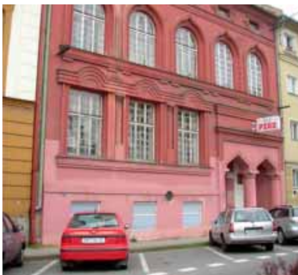
Budova bývalé židovské modlitebny na Božkově ulici
