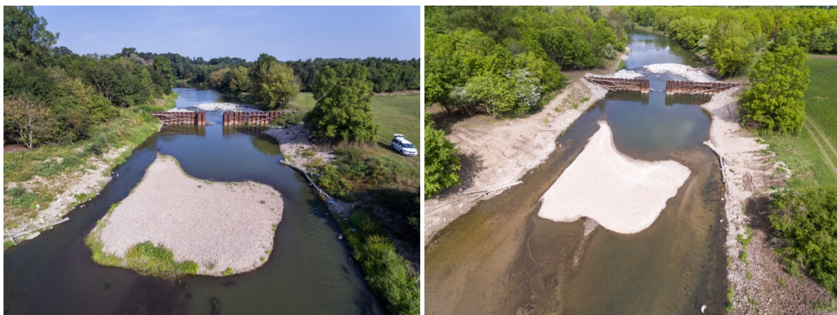
Obr. 23 a 24 Řeka Dyje na hraničním úseku pod Břeclaví, prvky vnitro korytové morfologie (v daném případě štěrkové lavice) mohou vzniknout samovolně, respektive díky ovlivnění průtokových poměrů člověkem vloženým objektem. Foto: Povodí Moravy, s.p., 2022 a 2023.
