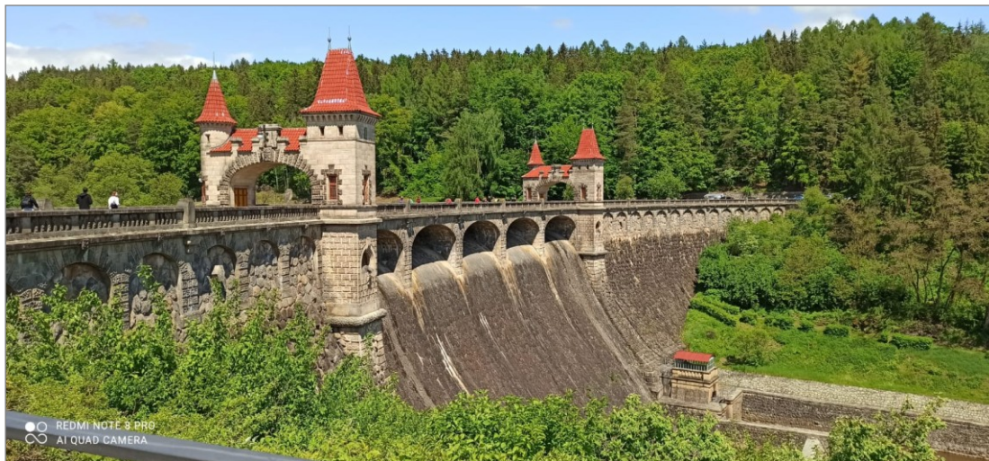
Obr. 57 Vodní nádrž Les Království byla vybudována v roce 1920. Foto: Tomáš Havlíček, 2023
