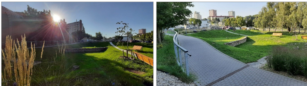
Obr. 61 a 62 Součástí výstavby Aquaparku v Brně-Kohoutovicích byl požadavek na řešení vsakování dešťové vody z celého areálu koupaliště. Výsledkem jsou suché nádrže s parkovou úpravou, které jsou využívány pro rekreaci. Stavba byla realizována v roce 2010. Foto: Z. Kučerová, 2023
