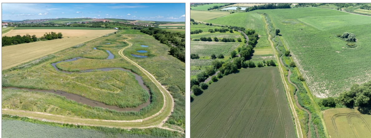
Obr. 43 a 44 Řeka Trkmanka, Velké Pavlovice. Jak je vidět na snímcích, může mít revitalizace i v rámci jedné realizace různou potřebnou šířku záboru. Přesto, že i na limitované šířce lze navrhnout podmíněně dostatečné řešení, je vždy vhodné hledat i plochy, kde je možné poskytnout větší šířku a řešení dostatečně rozvinout. Pro razantnější řešení jsou vhodné třeba podmáčené nebo častěji zaplavované lokality. Foto: Povodí Moravy, s.p., 2021
