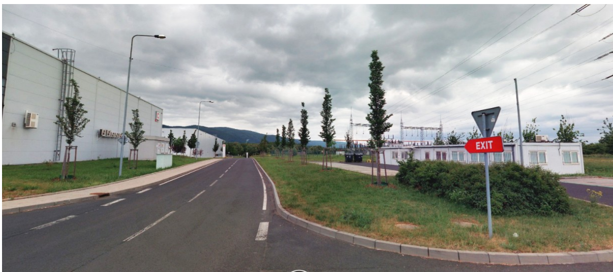
Obr. 58: Průmyslová zóna Krupka III u Teplic. Až vysázené stromy více povyrosteou, bude za nimi obrovská hala alespoň částečně schovaná. Foto: Seznam.cz, a.s., Cyclomedia Technology B.V, 13.6.2021
