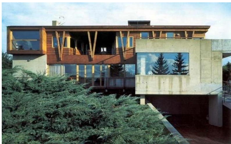
Obr. 3: Vila ve Vraném nad Vltavou, 1994–1995, (Josef Pleskot) Zdroj: archiweb.cz
