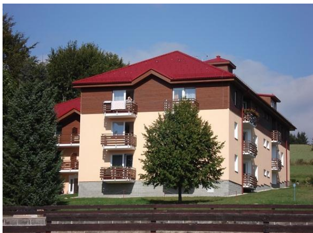
Obr. 100: Pastviny. Dům s pečovatelskou službou, 25 bytů, z toho 1 byt bezbariérový, 2002–2004 Zdroj: Fotoarchiv ÚÚR
