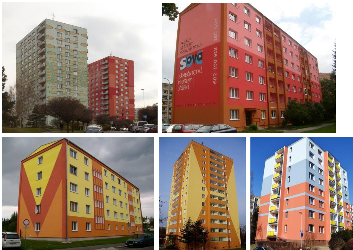
Obr. 120: Nevhodná barevnost a členění fasády
