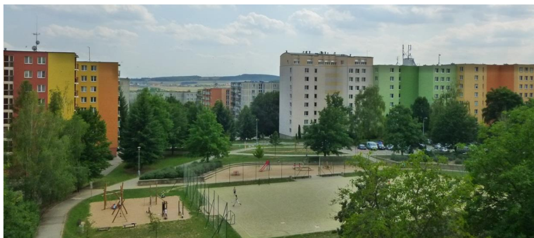
Obr. 112: Nevhodná nástavba v Brně-Bohunicích
