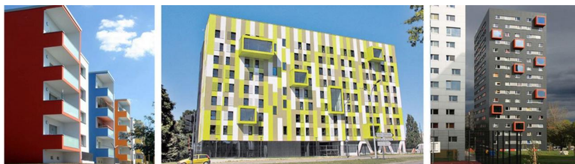
Obr. 121: Ukázka regenerace panelových domů v Německu
