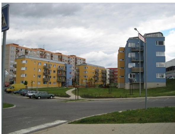
Obr. 101: Česká Lípa, soubor obytných domů s nájemními byty – II. etapa, 5 domů s celkem 80 byty, 2005–2008 Zdroj: Fotoarchiv ÚÚR
