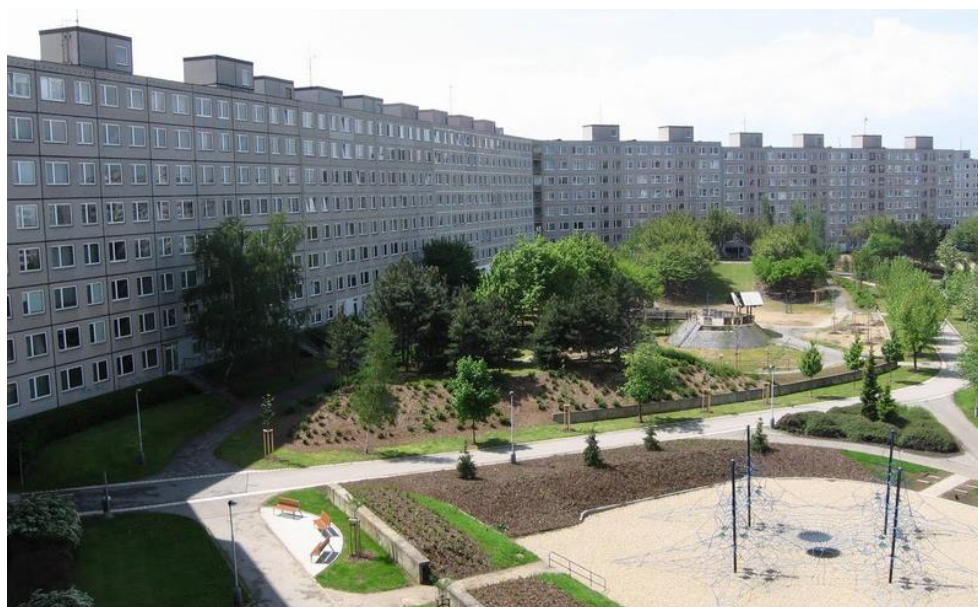
Obr. 110: Regenerace panelového sídliště v České Lípě
