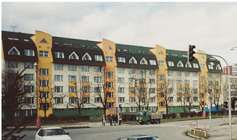
Obr. 122: Strakonice, regenerace a nástavba panelového domu
