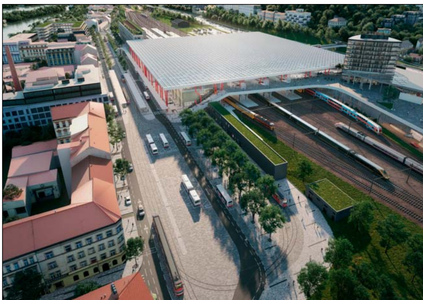
Terminál Smíchovské nádraží, Praha
