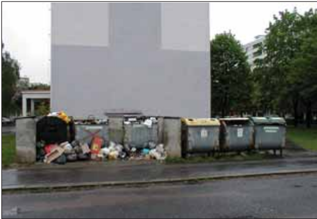
Regenerace panelového sídliště Pardubice – Pravý břeh Labe, II. etapa Vzhled sídliště před úpravou
