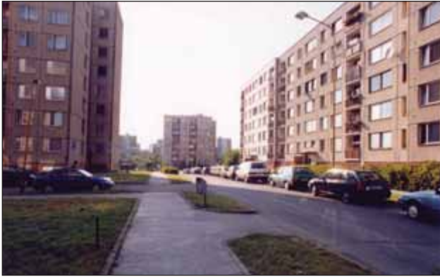
Regenerace panelového sídliště v Havířově – Šumbarku, II. etapa Stav komunikací před regenerací
